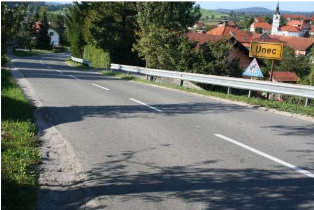
**Obrazložitev:** Ostri, nepregledni ovinki, ozka cesta, brez pločnika, velike hitrosti vozil.
