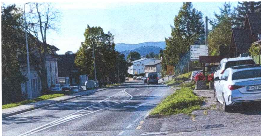
Lokacija št. 5: Križišče na Partizanski cesti od Avtostila proti pošti.
