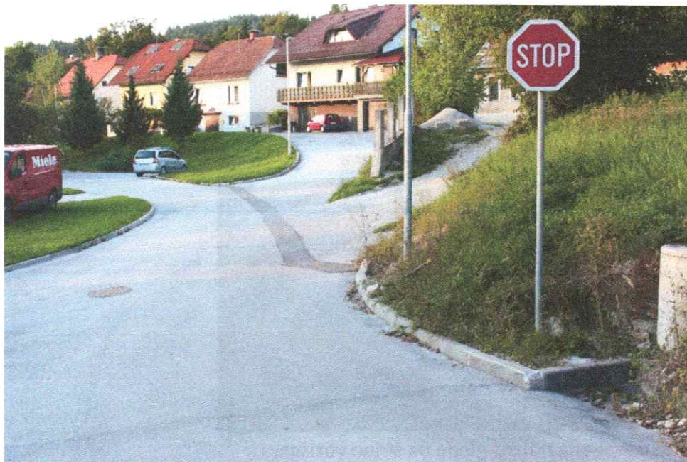
Obrazložitev: Nezaznamovan prehod in nepregledno križišče.
